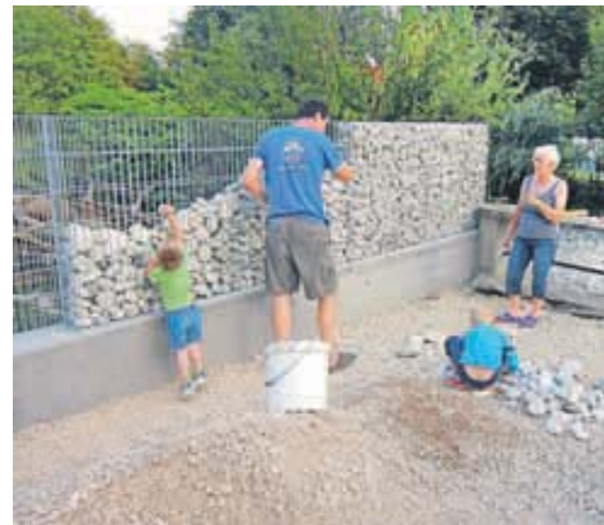
Veliko dela opravijo gasilci sami – tako so pred kratkim v delovni akciji uredili kamnito ograjo. / FOTO: PGD PODNART
